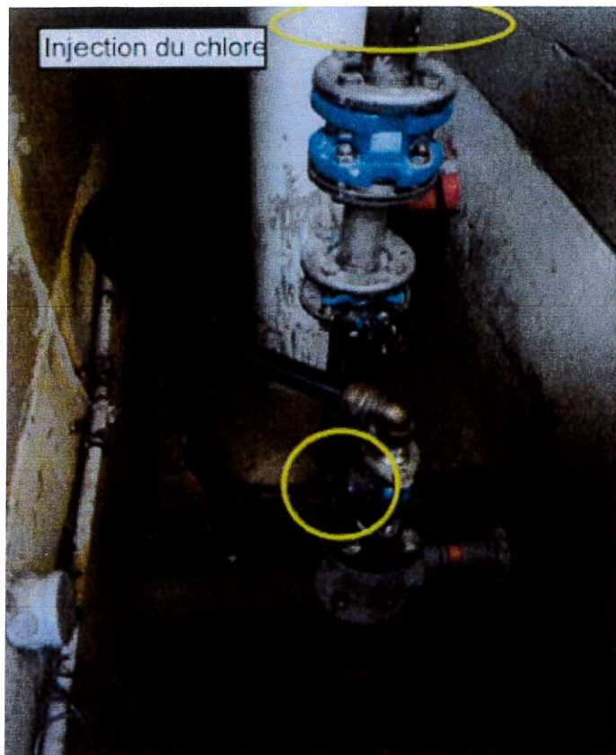
Poste de stockage Chlore gazeux au Local technique des forages
